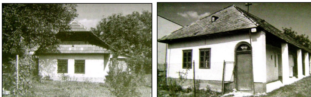
Príklady ľudovej architektúry, dom zo začiatku 20. storočia a z 20. rokov 20. storočia
